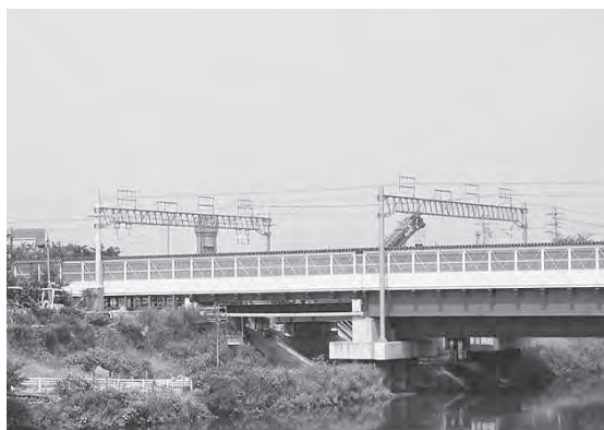
施工現場②
