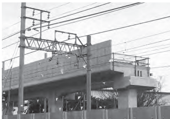
施工現場①
